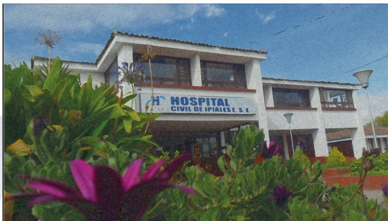
Figura 26. Fachada Ingreso Hospital Civil de Ipiales.
