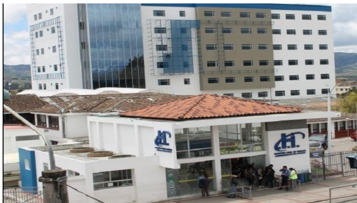
Figura 27. Nueva fachada y torre de Hospitalización, del Hospital Civil de Ipiiales.
